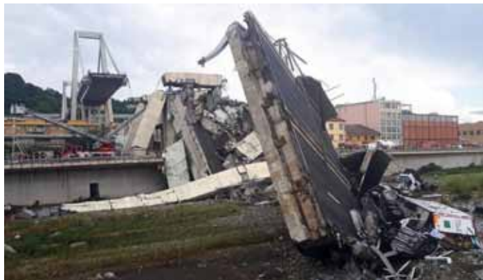
Genova. I resti del crollo del ponte Morandi
