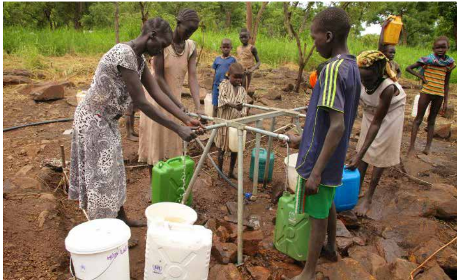
Leshoto. Un punto di raccolta per l'acqua da un pozzo interrato
