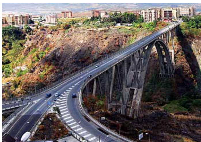
Il ponte Bisantis Morandi di Catanzaro
