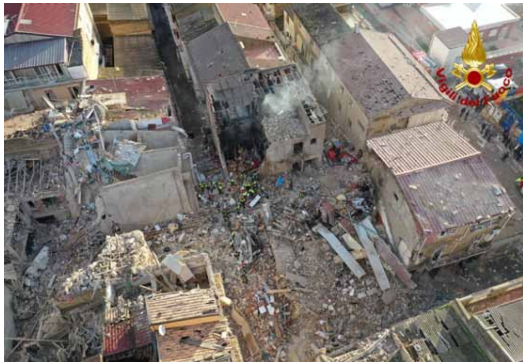
Ravanusa (Agrigento). Una veduta della vasta area delle abitazioni distrutte dalla grande esplosione di gas
