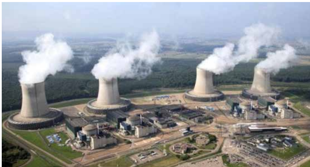
Una delle numerose centrali nucleari in Francia che risulta essere la nazione con più centrali nucleari
