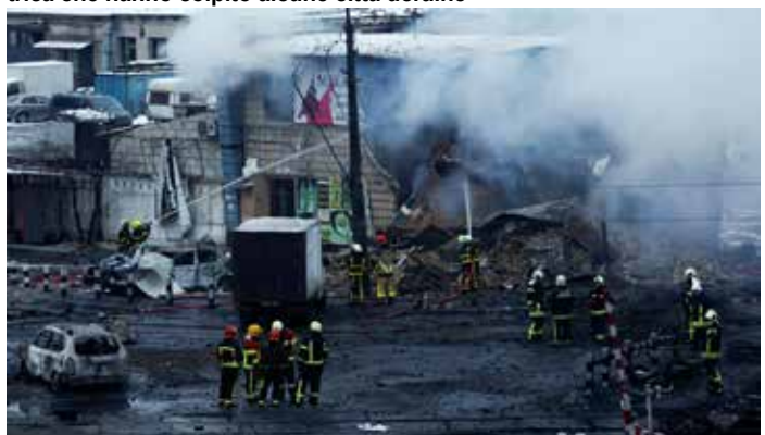
23 novembre 2022. L'intervento di soccorso su alcune abitazioni di Kiev distrutte dai missili russi
