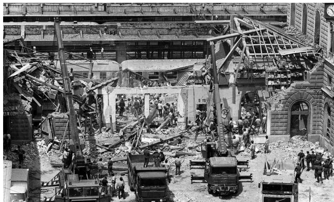
Bologna, 2 agosto 1980. Una immagine dei soccorsi e dei primi interventi sull'ala della stazione distrutta dalle bombe fasciste
