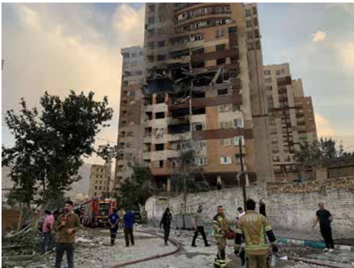
Teheran, 15 giugno 2025. Un edificio danneggiato dagli attacchi israeliani
