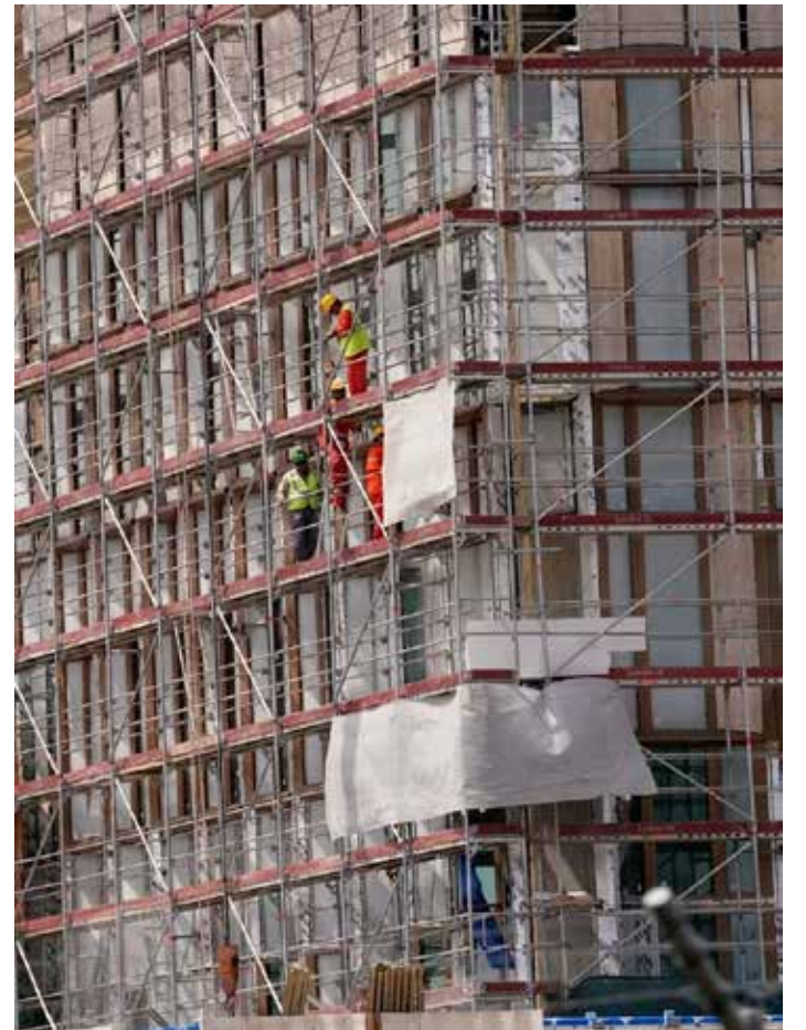
Alcuni operai indiani al lavoro nel cantiere del mastodontico consolato USA
