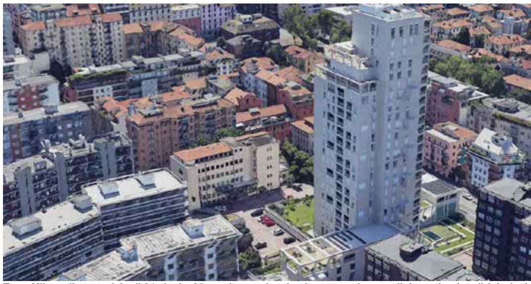
Torre Milano, il grattacielo di 24 piani e 85 metri costruito abusivamente al posto di due palazzine di 2-3 piani
