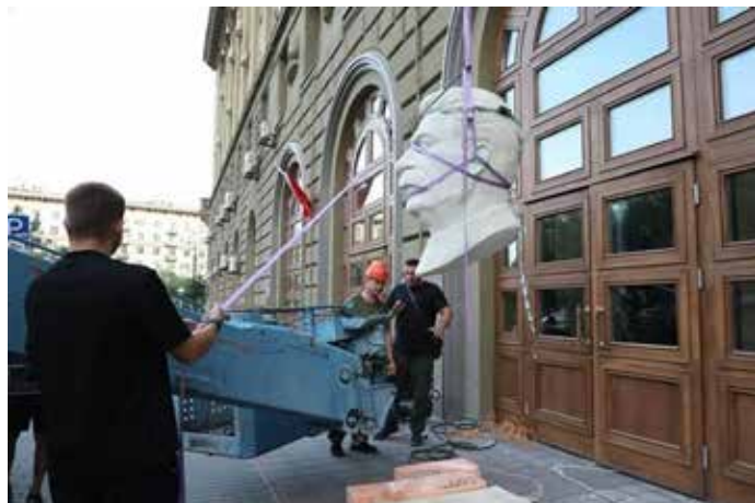
Tre momenti del restauro del bassorilievo di Stalin sulla facciata
